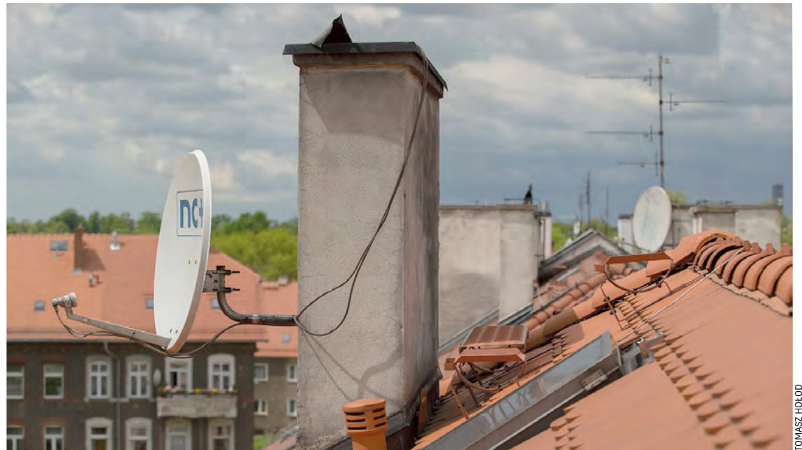
Część budynków przy ul. Chińskiej przeszła już remonty dachów w ubiegłych latach. Teraz czas na kolejne
