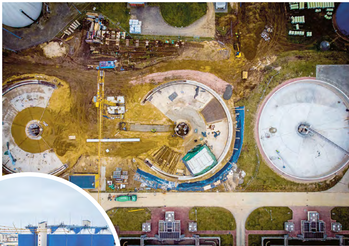
Blisko 100 pracowników już wykonuje roboty na terenie oczyszczalni
