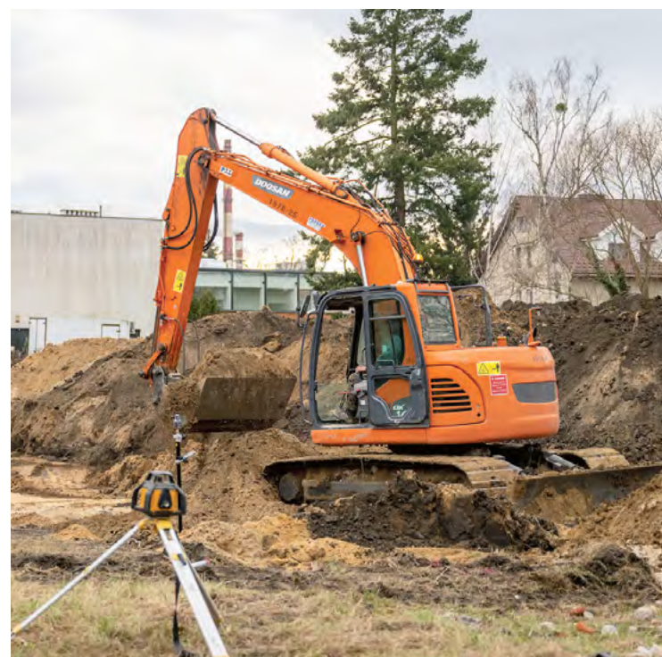
Budynek centrum opiekuńczego będzie miał powierzchnię 774 mkw.
