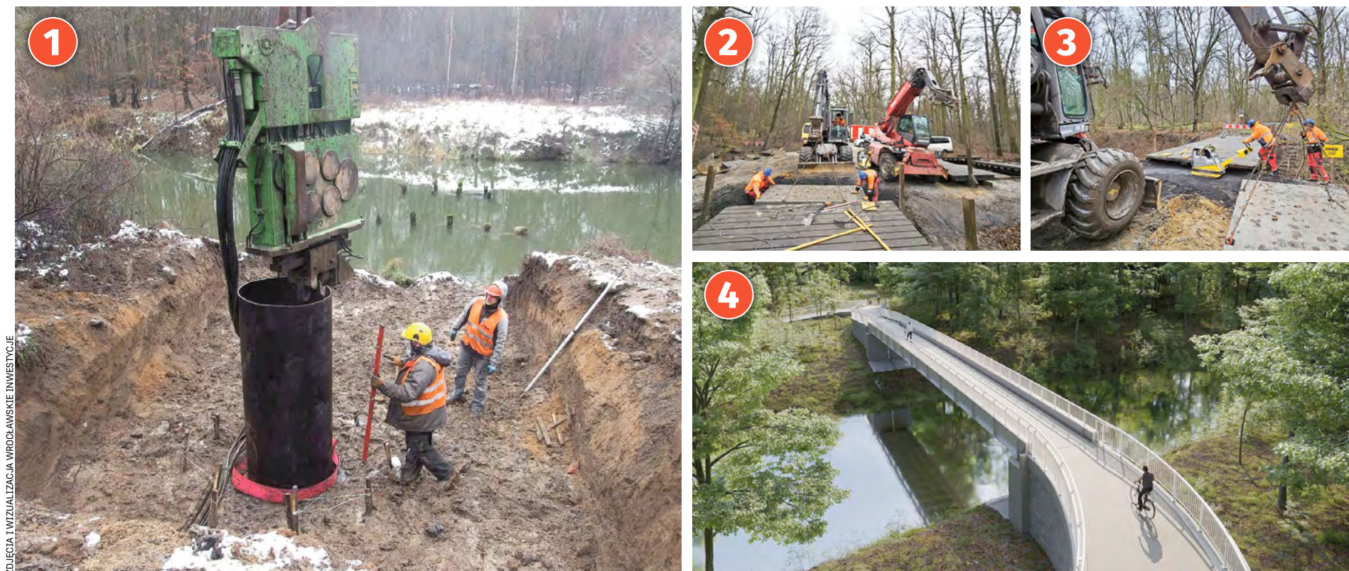
1. Montaż pali pod nowy most. 2. i 3. Wzmacnianie konstrukcji przeprawy nad ciekim Trzciana. 4. Wizualizacja nowego mostku nad Widawą – części Odrzańskiej Trasy Rowerowej
