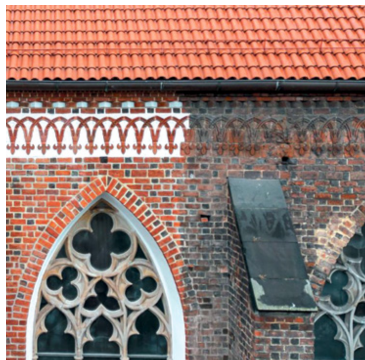
Odtworzyli fryz na elewacji kościoła przy pl. Dominikańskim
