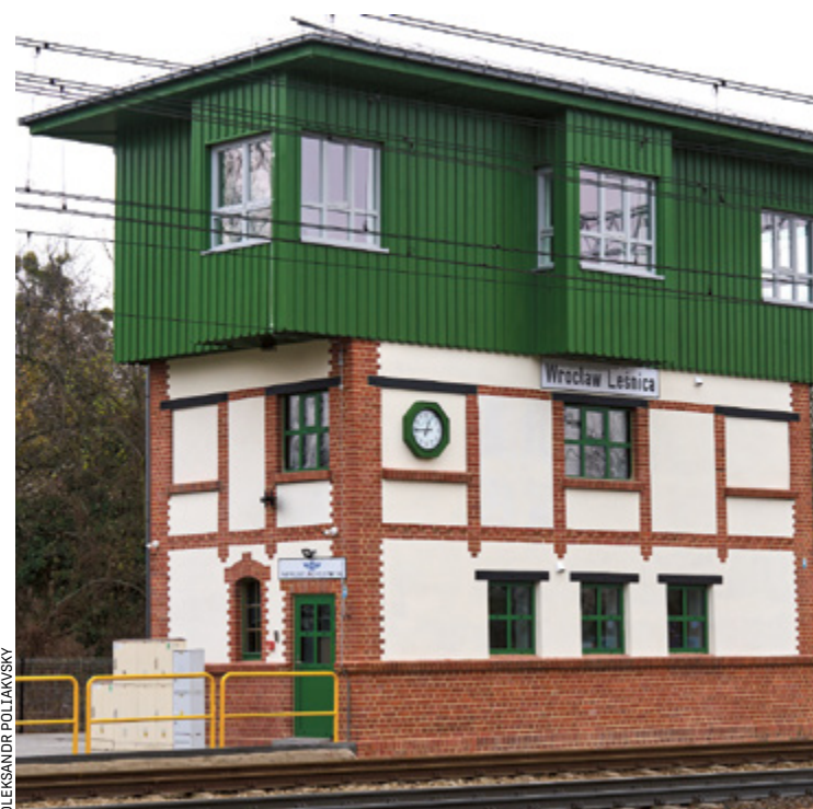
Świeżo zmodernizowana w ub. r. nastawnia na stacji Wrocław Leśnica
