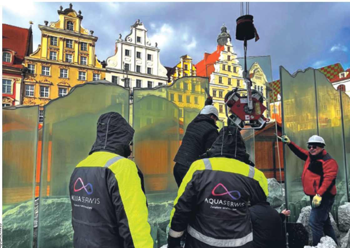
Pracownicy Aqua Serwis zakończyli montaż tafli ze szkła zbrojonego, laminowanego, potrójnie klejonego
