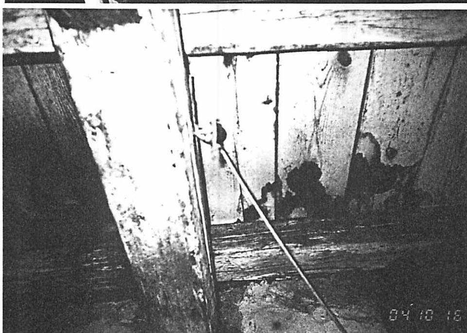
Elementy więzby dachowej - zawilgocone i zmurszałe.
