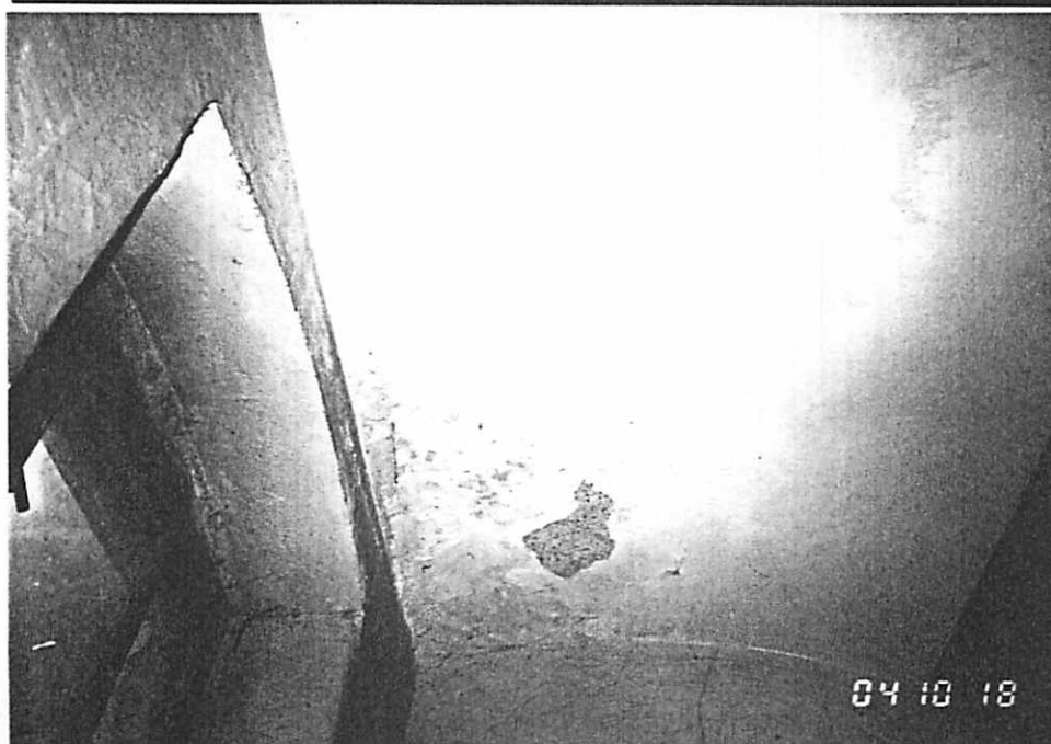
Podesty między III i II klatki schodowej
