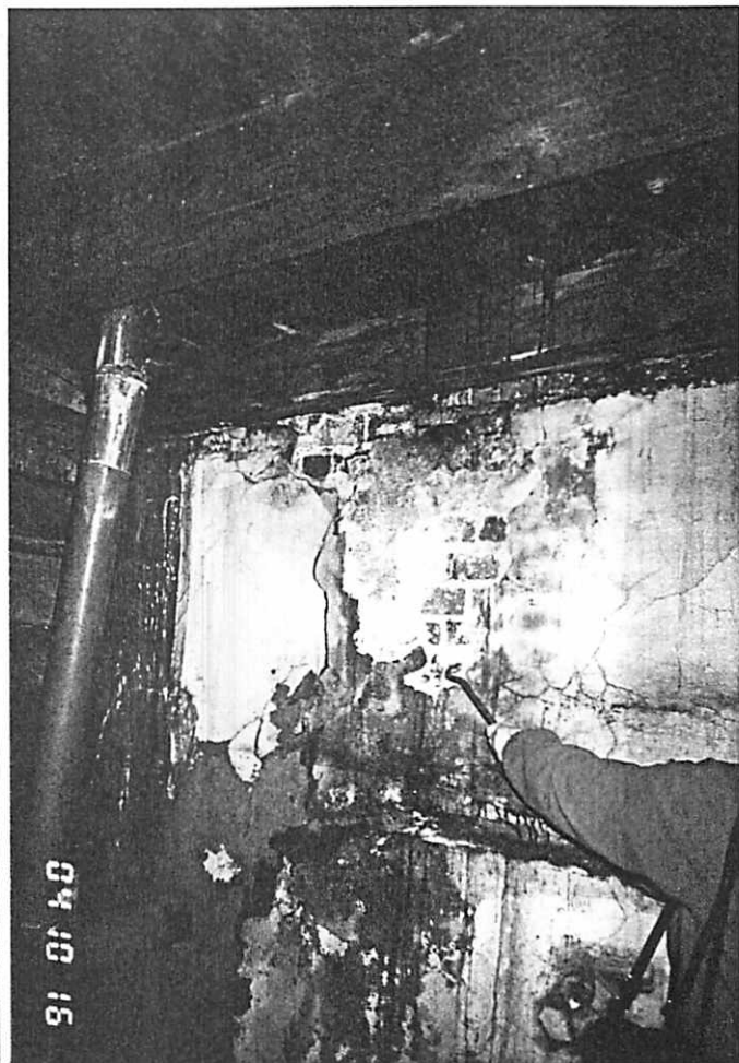
Zawilgocone kominy na strychu -odparzony tynk
