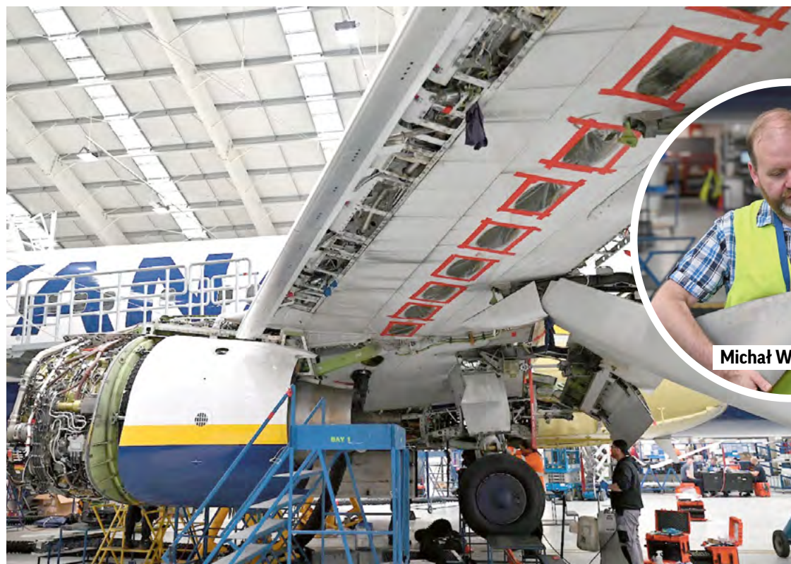
Na skrzydłach samolotu widać czerwoną taśmę – to oznaczenie elementów do wymiany lub naprawy
