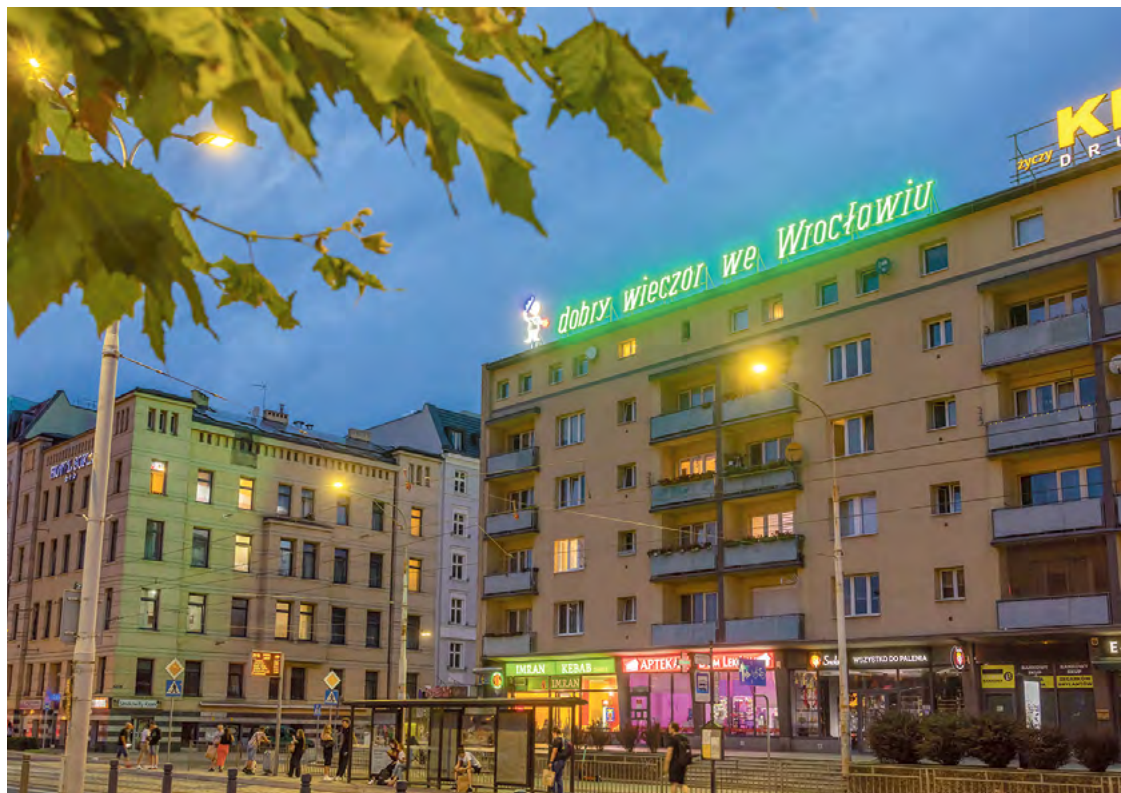
Od kilku dni trwają testy odrestaurowanego neonu, aby sprawdzić, czy wszystkie prace poszły naładzie
