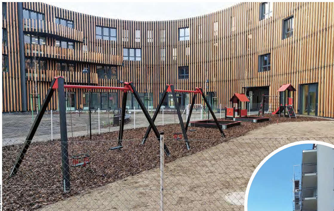
Trwa remont balkonów na Zakrzowie, a lada dzień robotnicy pojawią się na placu zabaw na Nowych Żernikach
