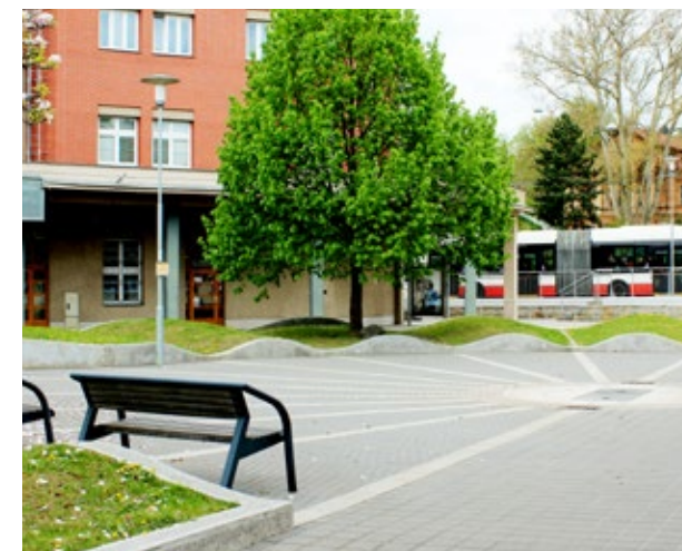
Fotografie Gdańsk, ciąg pieszo-rowerowy wykonany z betonu jamistego - prawidłowe wykonanie zapewnia komfort użytkownika ( fot. A. Romaniak) Brno, pętla tramwajowa Pisarky - odwodnienie ciągu pieszego, przy zastosowaniu zróżnicowanej nawierzchni, projekt Evy Wagnerowej (fot. E. Walter)
