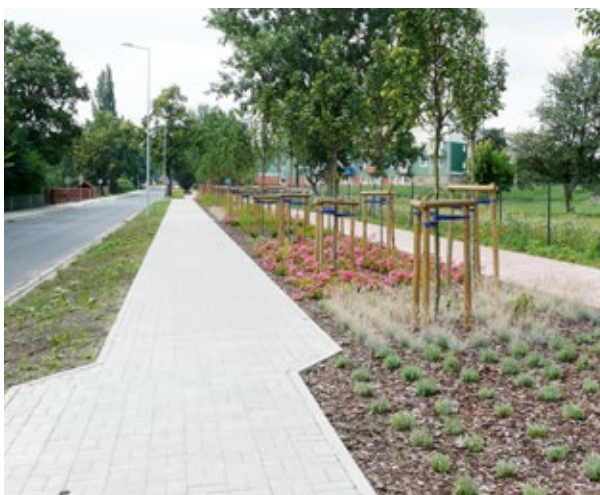
Fotografie Gdańsk, ciąg pieszo-rowerowy wykonany z betonu jamistego - prawidłowe wykonanie zapewnia komfort użytkownika ( fot. A. Romaniak) Brno, pętla tramwajowa Pisarky - odwodnienie ciągu pieszego, przy zastosowaniu zróżnicowanej nawierzchni, projekt Evy Wagnerowej (fot. E. Walter)
