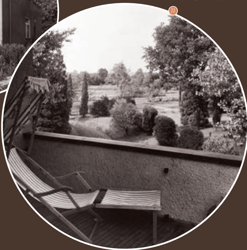
Dom dwurodzinny nr 26/27, proj. Theo Effenberger, taras na dachu sekcji nr 26, widok od strony pd., ok. 1930. Muzeum Architektury we Wrocławiu, Mat IIIb 533-8
