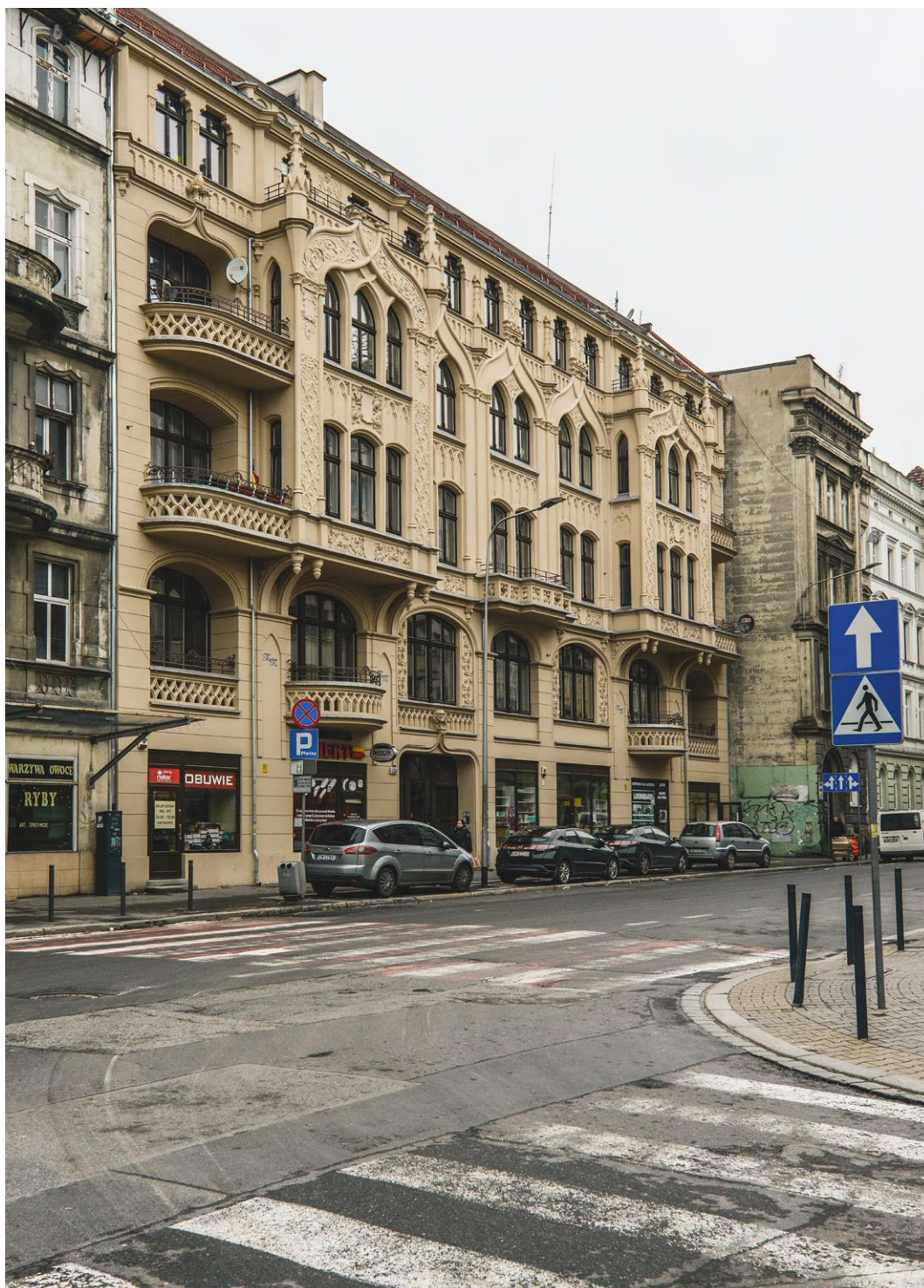
Kamienica przy ul. Krasieńskiego na Przedmieściu Oławskim po remoncie w 2019 r. Fot. Artur Busz, Wrocławska Rewitalizacja
