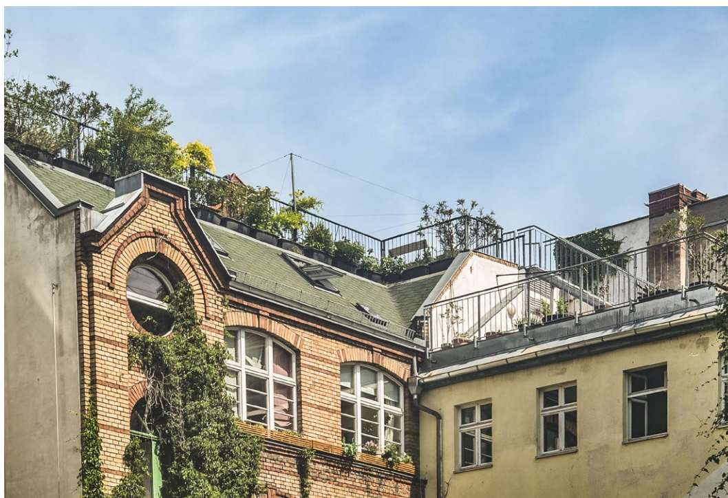
Potencjał dach - przykład ogrodu dla mieszkańców w berlińskiej dzielnicy Kreuzberg. Fot. Lucyna Maury, Wrocławska Rewitalizacja
