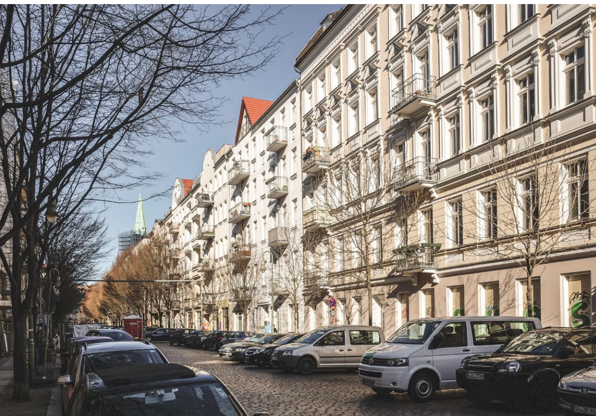
Ciąg odrestaurowanych elewacji w dzielnicy Prenzlauer Berg w Berlinie. Fot. Thomas Arns
