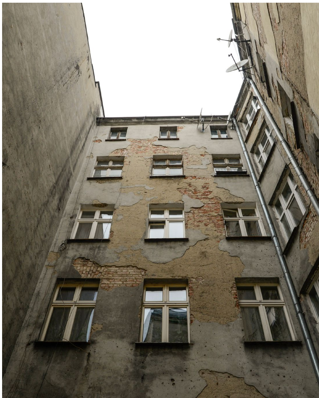
Typowo wrocławski (i berliński) sposób łączenia oficyny z kamienicą frontową. Skośna ściana umożliwia doświetlenie tzw. pokoju berlińskiego (pomieszczenia na styku domu frontowego i oficyny). Fot. Artur Busz, Wrocławska Rewitalizacja
