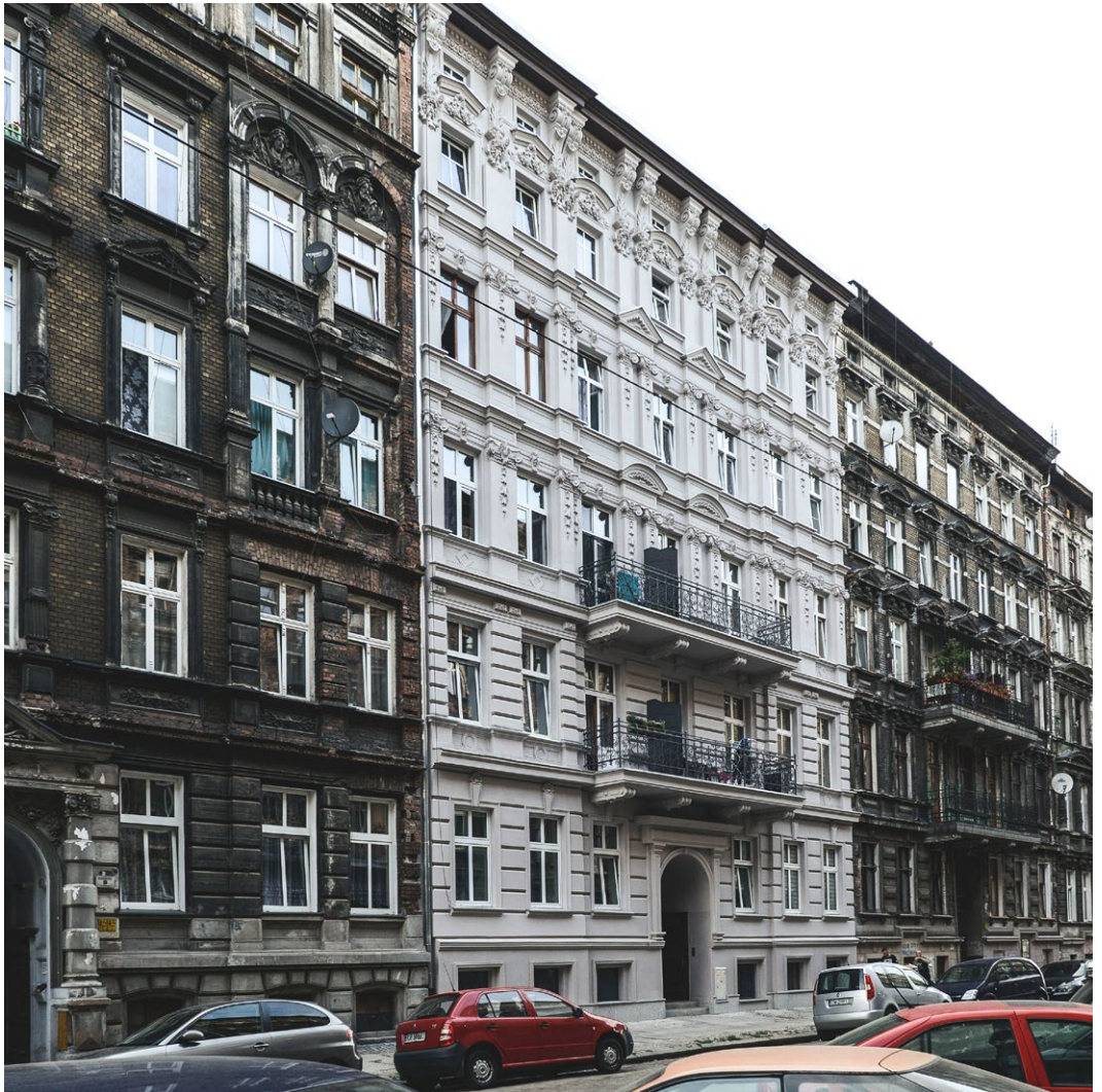
Kamienica przy ul. Mierniczej 7 po remoncie w 2019 r. Fot. Artur Busz, Wroctawska Rewitalizacja
