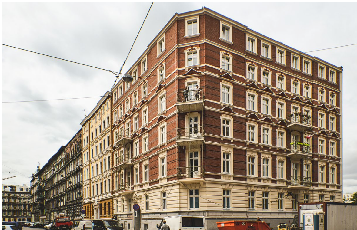
Jedna z kamienic na Przedmieściu Oławskim wyremontowana przez Zarząd Zasobu Komunalnego w 2019 r. Fot. Lucyna Maury, Wrocławska Rewitalizacja
