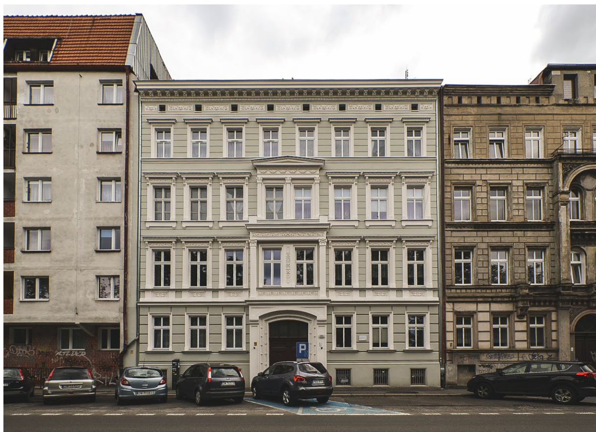
Przykład prawidłowo przeprowadzonego remontu - wyodrębniona strefa przyziemia, podkreślone detale jak gzymsy i obramowania, jednolite okna, stonowana kolorystyka. Fot. Wrocławska Rewitalizacja
