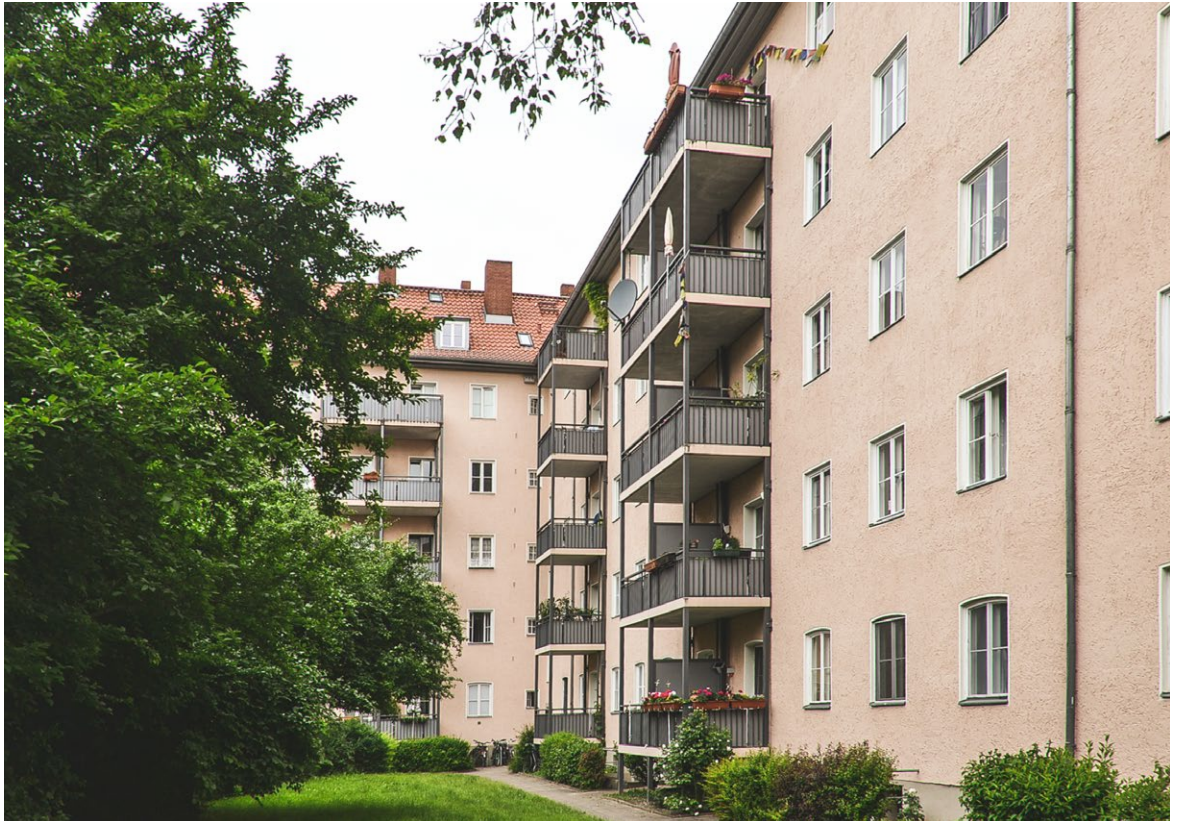
W tym kwartale w berlińskiej dzielnicy Friedenau balkony dostawiono do elewacji podwórkowej. Dzięki temu mieszkańcy zyskali dodatkową przestrzeń i możliwość aktywniejszych kontaktów sąsiedzkich. Fot. Lucyna Maury, Wrocławska Rewitalizacja
