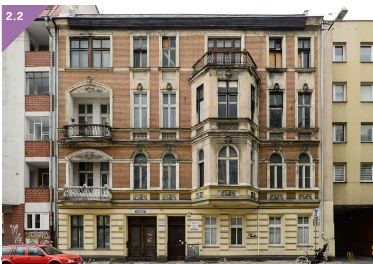
Fot. Elewacja frontowa kamienicy przy Hauke-Bosaka 11 (autor: Artur Busz, Wrocławska Rewitalizacja).
