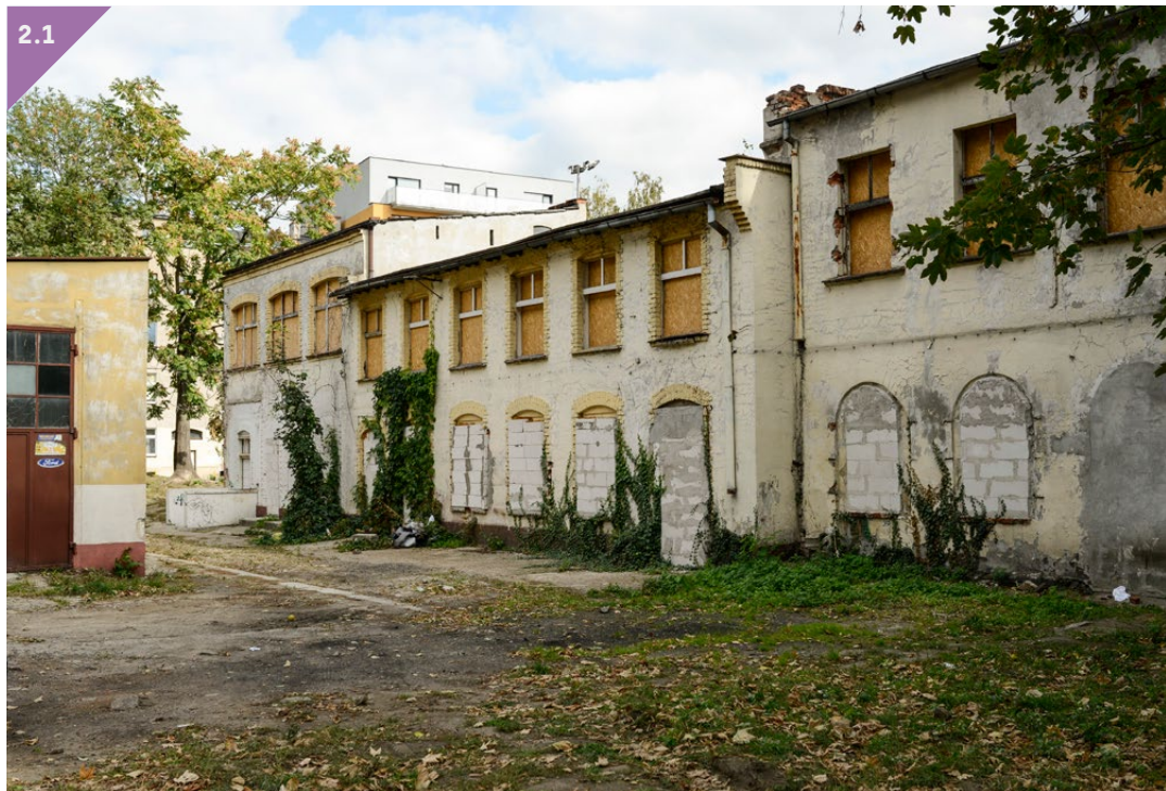
Fot. Oficyny możliwe do zagospodarowania (autor: Artur Busz, Wrocławska Rewitalizacja).
