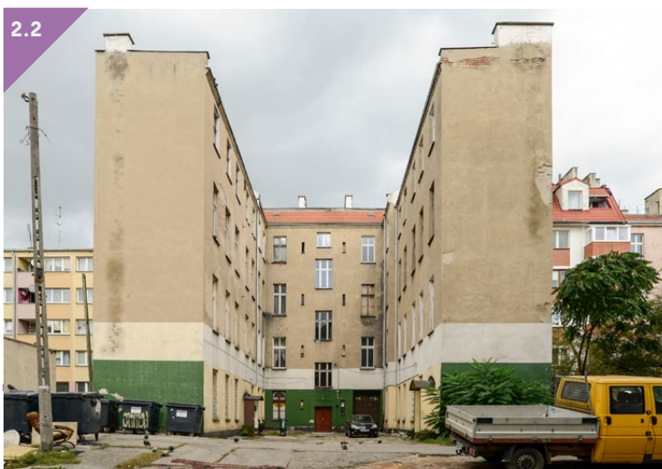
Fot. Od strony podwórza kamienica posiada 2 skrzydła (autor: Artur Busz, Wrocławska Rewitalizacja).
