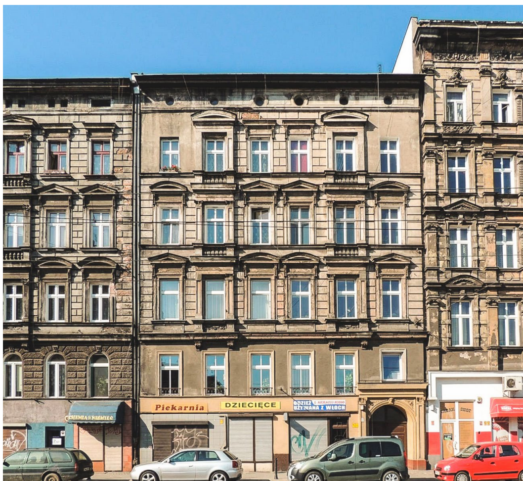
Ulica Traugutta to główna oś prowadząca z centrum Wrocławia przez Przedmieście Oławskie. Jednym z wyzwań rewitalizacji obszarów śródmiejskich jest ożywienie gospodarcze, co możliwe jest m.in. poprzez remonty pustostanów. Fot. Wrocławska Rewitalizacja
