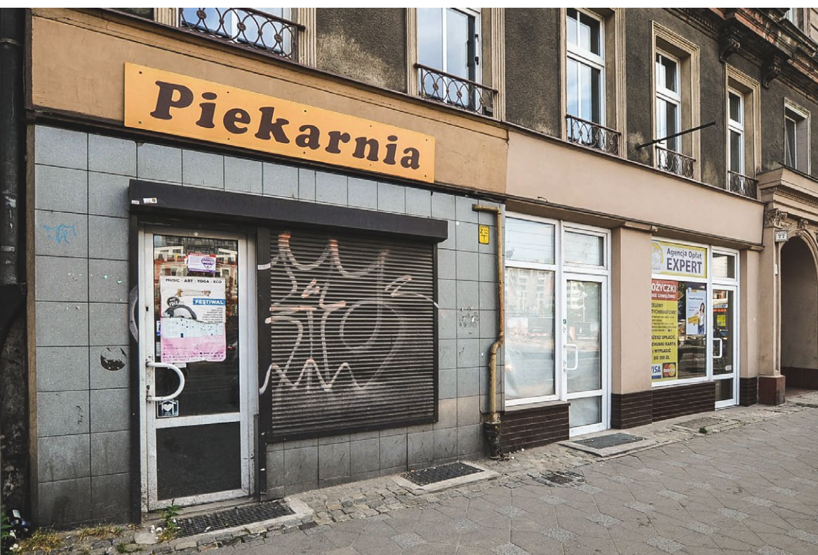
Witryna lokalu przy ul. Traugutta 77 – przed i po remoncie. Fot. Lucyna Maury, Wrocławska Rewitalizacja
