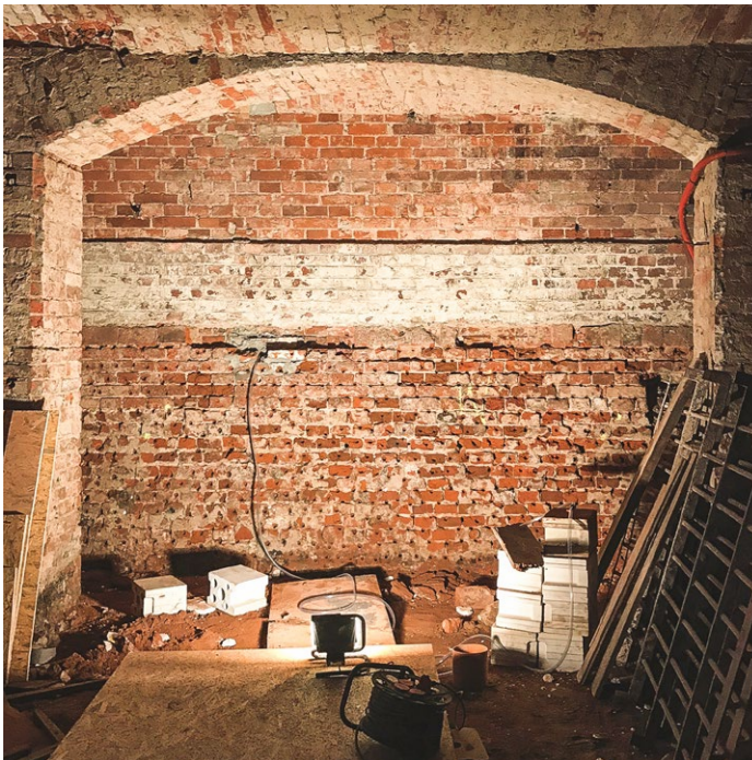
Iniekcja ściany zewnętrznej, zapobiegająca przed zawilgoceniem ścian w lokalu. Fot. Paweł Wojdyłak, Wrocławska Rewitalizacja
