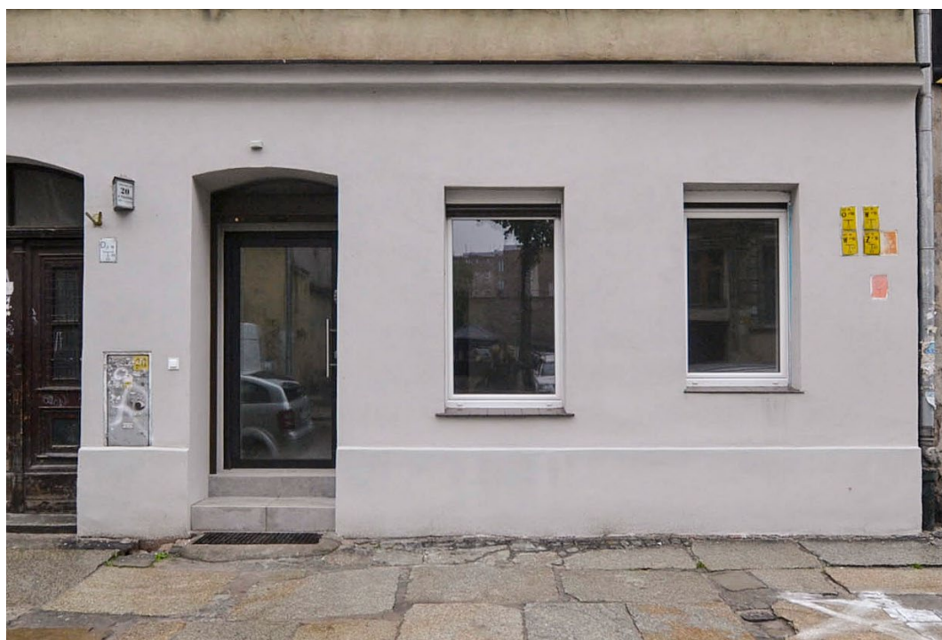
Przy okazji remontu lokalu przy ulicy Prądyńskiego 20, wymontowana została elewacja, co znacznie wpłynęło na estetykę przestrzeni ulicy. Fot. Lucyna Maury, Wrocławska Rewitalizacja
