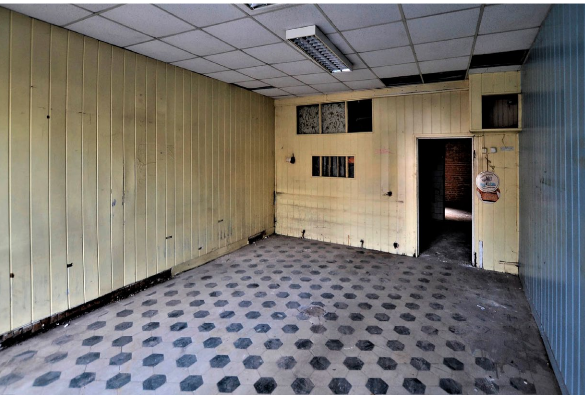
Wnętrze lokalu przy ul. Traugutta 77 - przed i po remoncie. Fot. Lucyna Maury, Wrocławska Rewitalizacja
