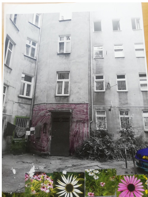
Projekt 18 zakłada pomalowanie fragmentu elewacji budynków.
