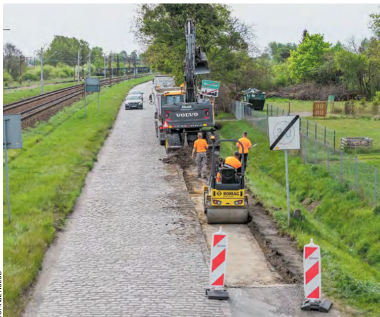
Trwają prace prowadzone przez ZDiUM przy poszerzaniu ul. Mościckiego
