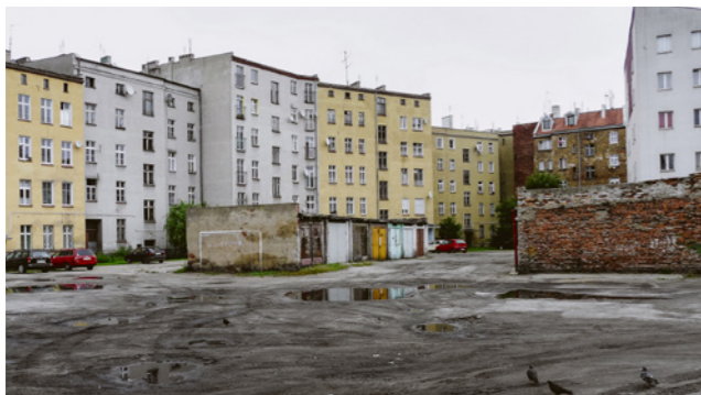
Remonty podwórek: mieszkańcy odzyskują swoją najbliższą przestrzeń do wypoczynku i rekreacji. Kwartal między pl. Staszica oraz ulicami Bolesława Chrobrego i św. Wincentego przed i po remoncie. Fot. Urszula Hamkało, ZZK
