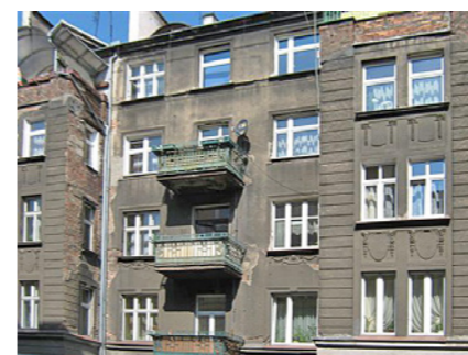
Kamienica przy ul. Kazimierza Jagiellończyka przed i po remoncie. Fot. archiwum Atena Sp. z o.o.
