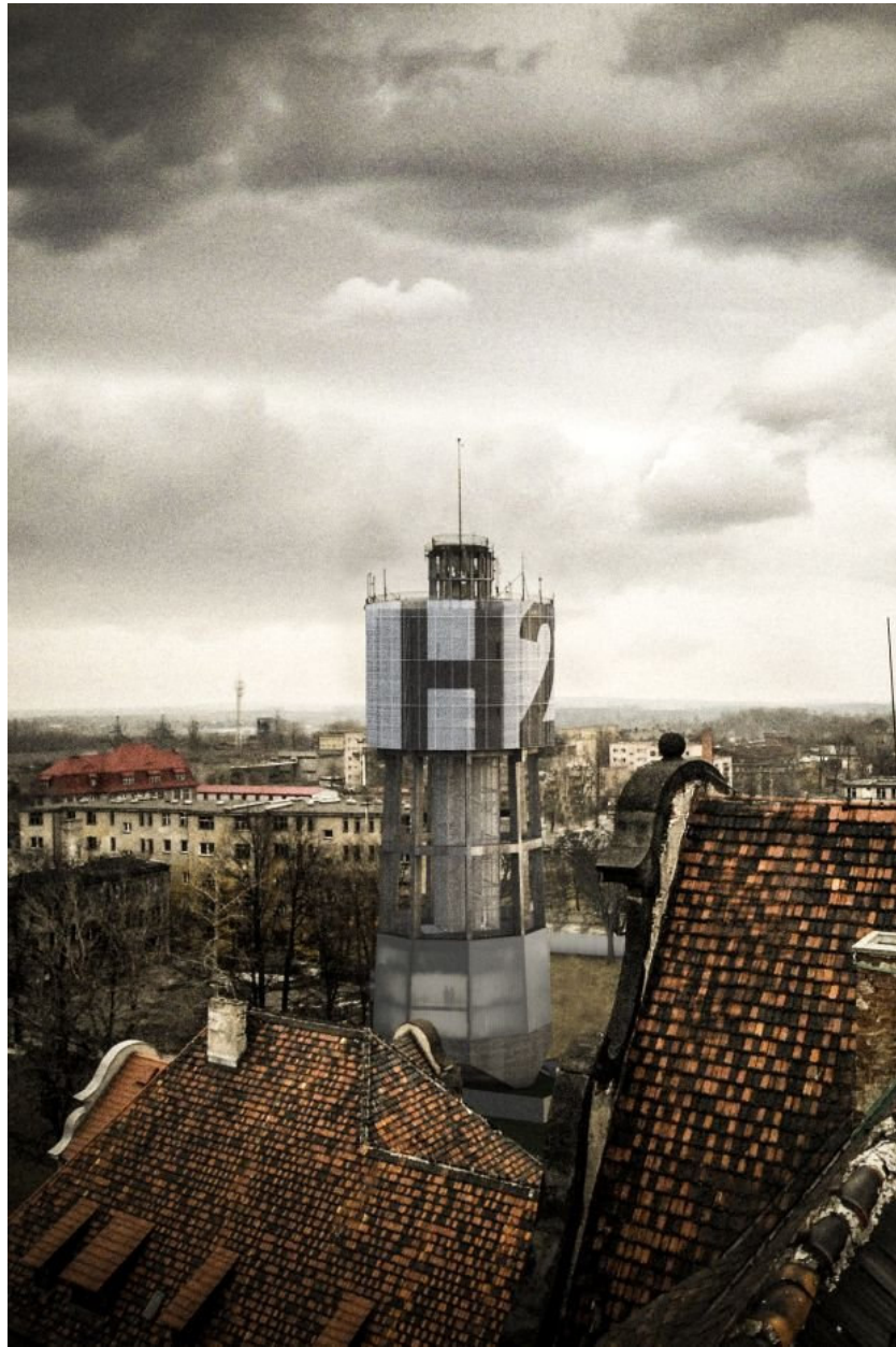
Serwerownia – projekt Medusa Group Bytom, Polska
