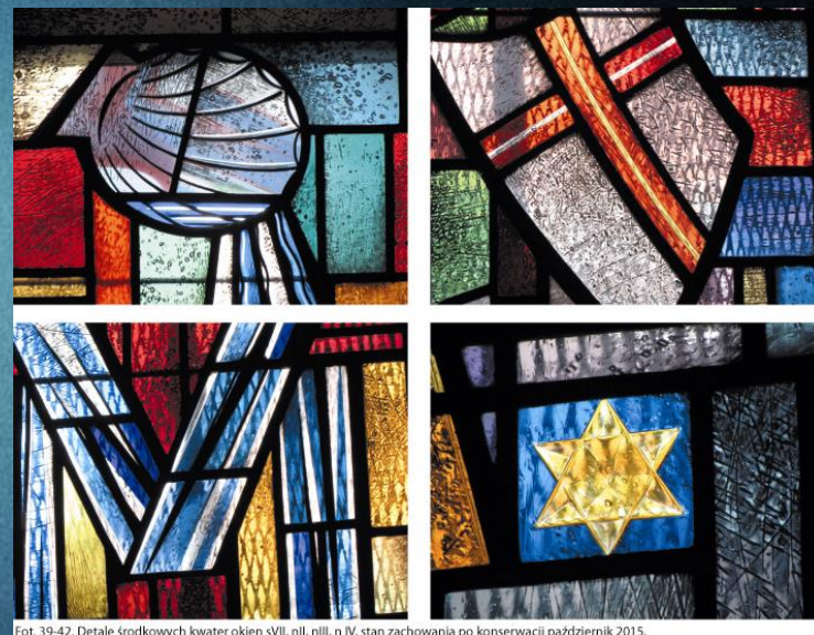
Fot. 39-42. Detale środkowych kwater okien sVII, nIII, nIII, nIV, stan zachowania po konserwacji październik 2015.
