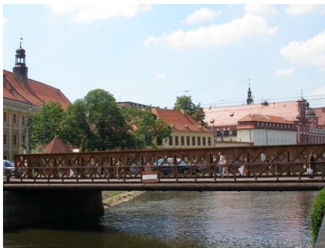
Fot. 13: Most Piaskowy od strony wody górnej.
