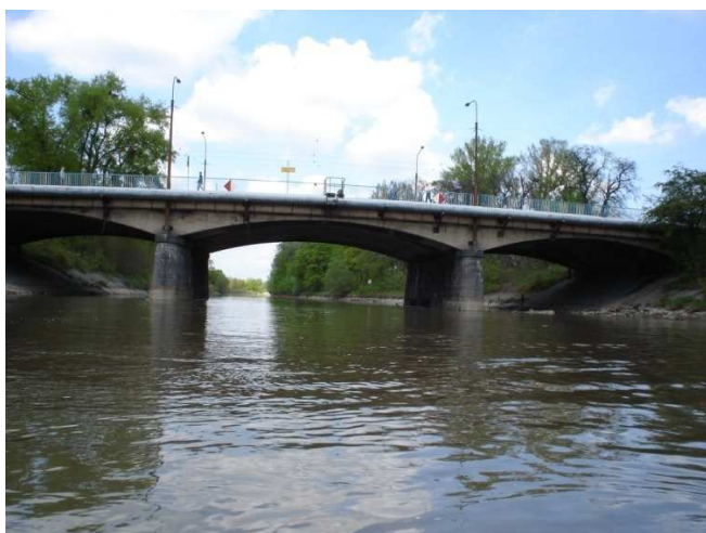
Fot. 40: Most Szczytnicki przed remontem w roku 2005 – widok z koryta.
