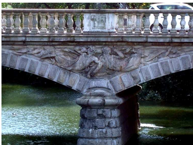
Fot. 34: Środkowy filar mostu Oławskiego.
