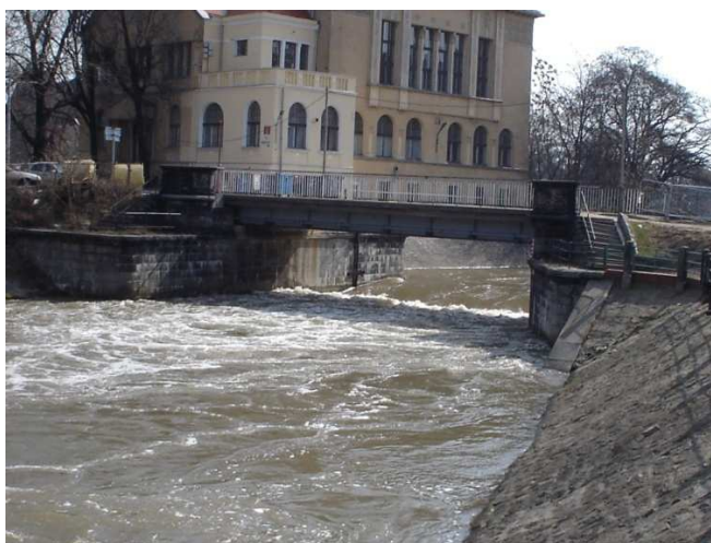
Fot. 10: Most św. Macieja przed remontem - zdjęcie z 2003 r.
