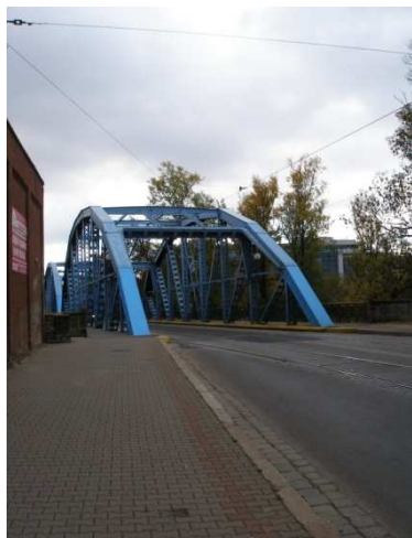
Fot. 4: Wejście na most W. Sikorskiego od strony Kępy Mieszczańskiej.
