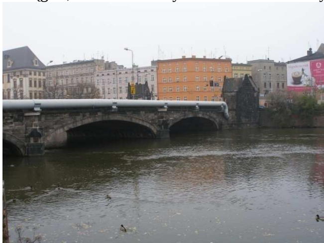
Fot. 6: Most Pomorski Południowy od strony Kępy Mieszczańskiej.
