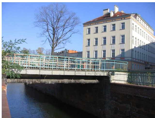
Fot. 23: Most Słodowy od dolnej wody.
