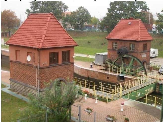
Fot. 55: Budynek pomocniczy i budynek maszynowni śluzy Różanka.
