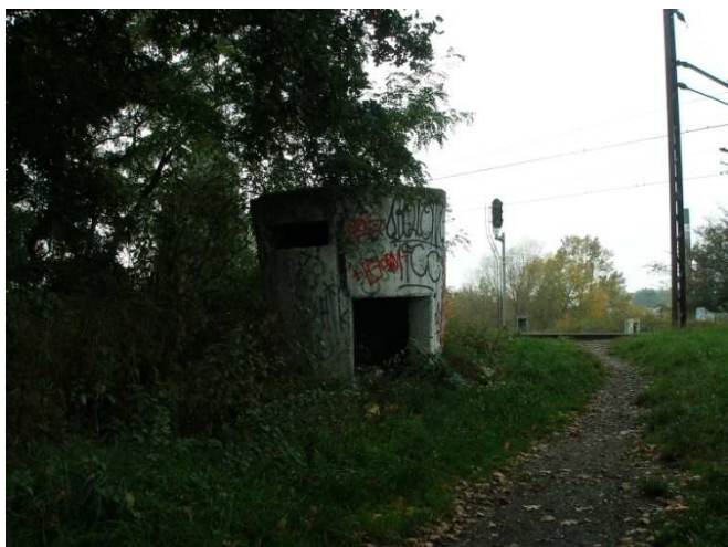
Fot. 36: Bunkier wartowniczy przy torach kolejowych.
