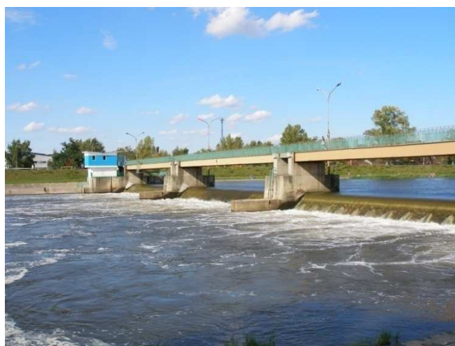
Fot. 2: Jaz Opatowice - widok z lewego brzegu.
