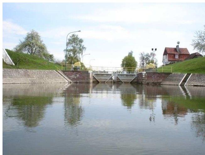
Fot. 6: Śluza Opatowice od strony wody dolnej – widok z koryta.
