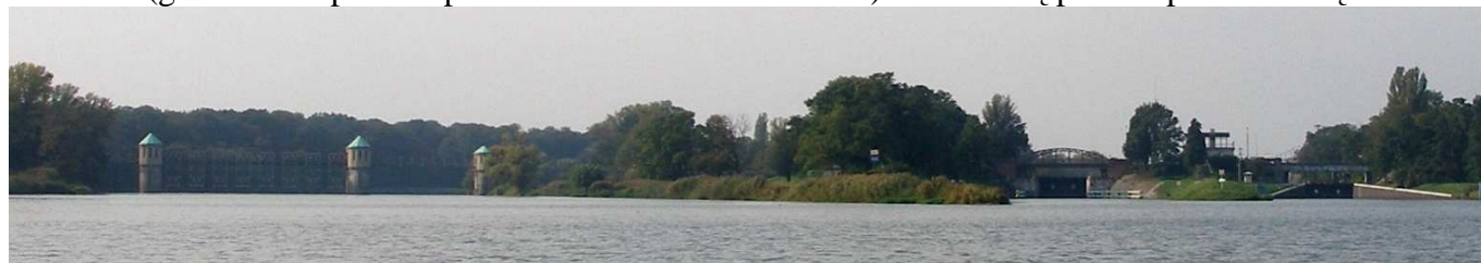
Fot. 57: Panorama stopnia wodnego Rędzin. Po lewej widoczny jaz a po prawej śluza.
