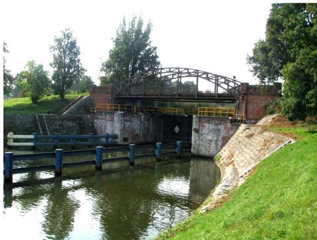
Fot. 65: Most nad śluzą Rędzin I - widok od strony dolnej wody.
