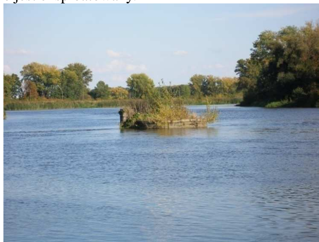
Fot. 4: Filar w korycie Odry dawnego jazu kozłowo-iglicowego - widok z prawego brzegu.
