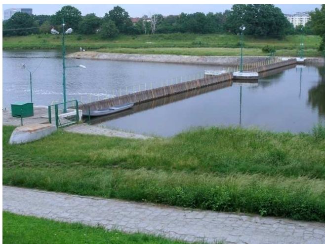
Fot. 32: Jaz Psie Pole w czasie piętrzenia wody.
