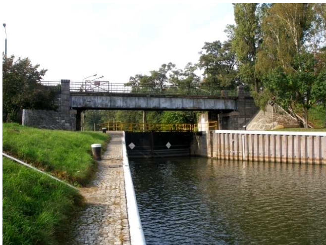
Fot. 64: Most nad śluzą Rędzin II - widok od strony dolnej wody.
