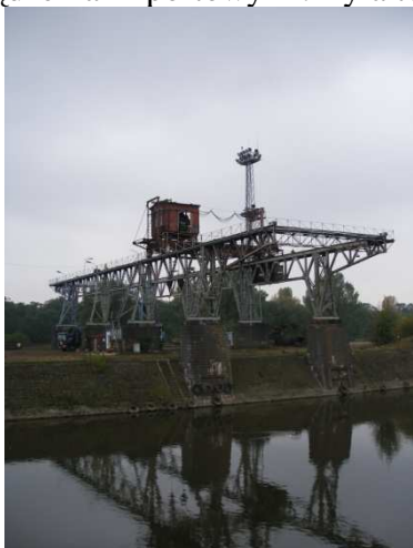
Fot. 49: Stara suwnica portowa.
