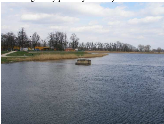
Fot. 3: Filar w korycie Odry dawnego jazu kozłowo-iglicowego - widok z współczesnego jazu Opatowice.
