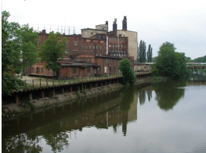
Fot. 34: Nabrzeże przeładunkowe dawnego browaru przy Kanale Miejskim.
