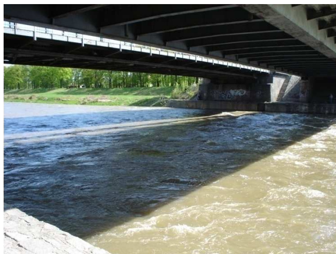
Fot. 25: Zafalowanie wody w czasie dużych przepływów spowodowane przez leżący na dnie złożony jaz Zacisze.
