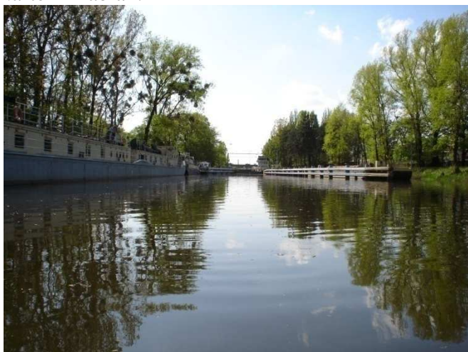
Fot. 20: Śluza Zacisze od górnej wody - widok z koryta.
