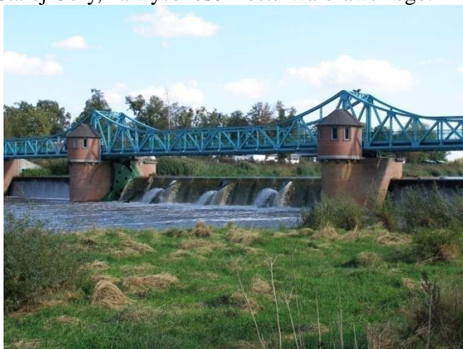
Fot. 11: Jaz Bartoszowice od wody dolnej - widok z lewego brzegu.
