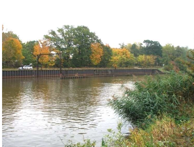
Fot. 14: Port Przeładunkowy Paliw Płynnych.
