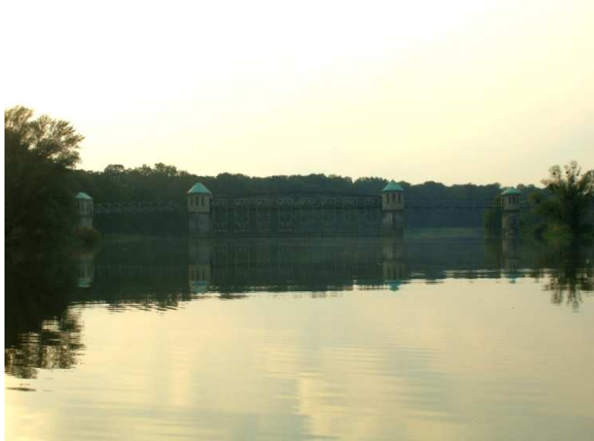
Fot. 58: Jaz Rędzin od strony wody górnej - widok z koryta.
