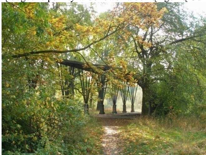
Fot. 9: Betonowa wiata na wyspie Opatowickiej.
