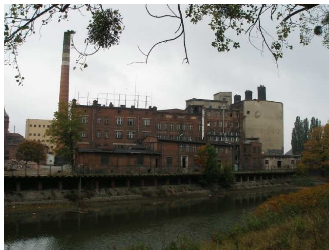
Fot. 35: Zabudowania i nabrzeże przeładunkowe dawnego browaru przy Kanale Miejskim.
