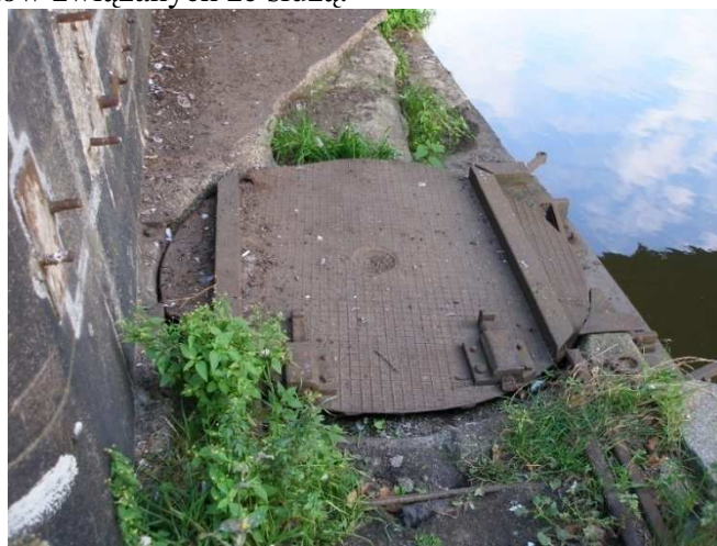
Fot. 23: Obrotnica wagonów do przewozu iglic, umożliwiająca wjazd wagonika bezpośrednio na konstrukcję jazu.
