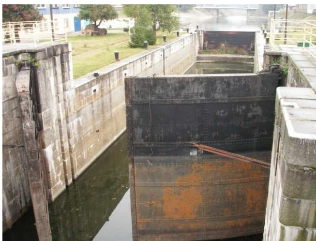
Fot. 54: Komora śluzy Miejskiej od strony górnych wrot.
