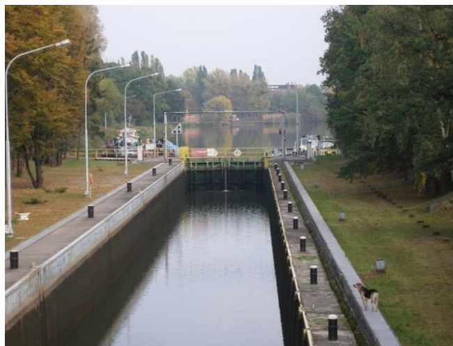
Fot. 21: Komora śluzy Zacisze - widok z mostu Jagiellońskiego.
