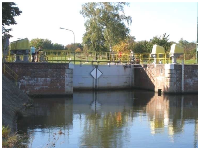
Fot. 5: Śluza Opatowice od strony wody górnej – widok z prawego brzegu.
