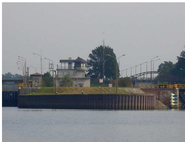
Fot. 63: Sterówka śluz Rędzin od strony dolnej wody.
