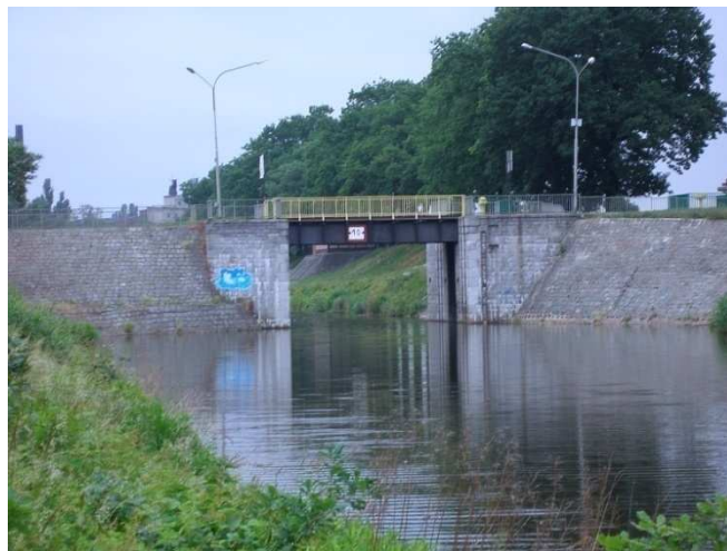
Fot. 31: Otwarta brama powodziowa - widok z lewego brzegu.
