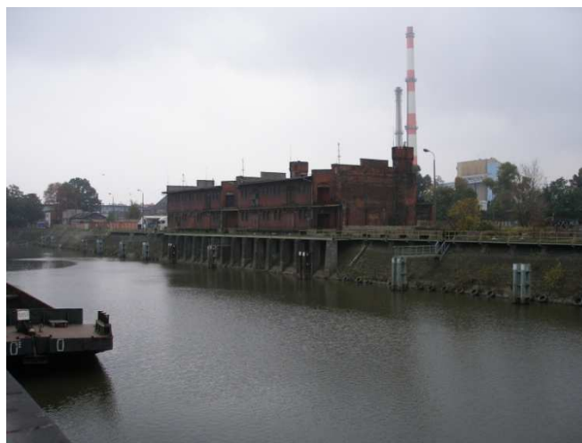
Fot. 48: jeden z magazynów portowych nad brzegiem basenu portowego.
