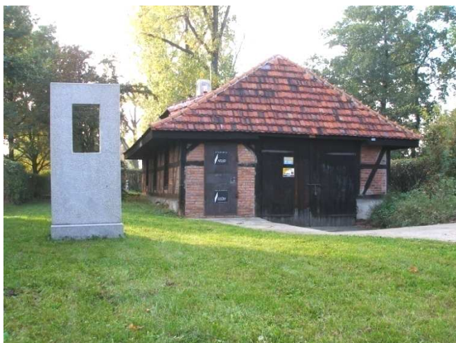
Fot. 24: Szopa jazowa do przechowywania iglic jazu Zacisze. Od czasu zaprzestania eksploatacji jazu, użytkowana jako pracownia artystyczna.
