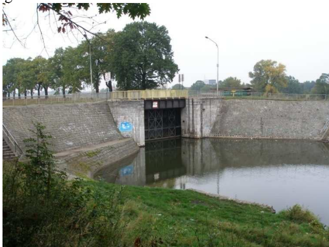
Fot. 30: Zamknięta brama powodziowa - widok z lewego brzegu.
